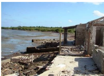
Destrucción de las obras costeras por la mala ubicación de las construcciones y la acción del viento y el oleaje.
