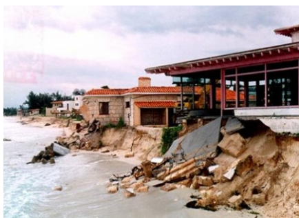
Destrucción de las obras costeras por la mala ubicación de las construcciones y la acción del viento y el oleaje.
